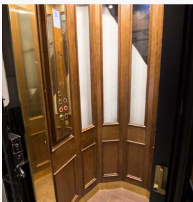
Specialbyggd hisskorg i trä med detaljer i mässing samt spegelväggar.
