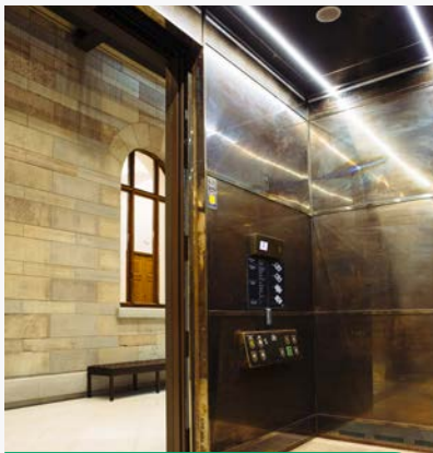
Specialbyggd hisskorg med oxiderad plåt och mässing.
