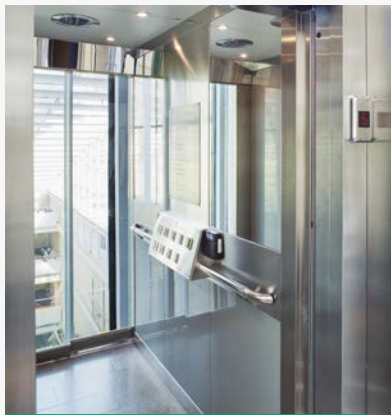
Specialbyggd hisskorg i rostfritt stål med glasdörrar.
